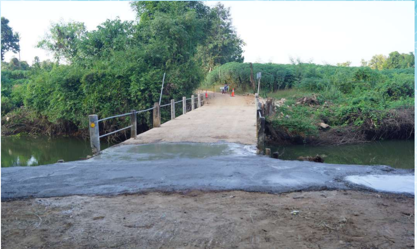
งานซ่อมแซมคอสะพานข้ามคลองแม่รำพัน หมู่ที่ 1 ตำบลหนองหญ้าปล้อง อำเภอบ้านด่านลานหอย จังหวัดสุโขทัย งบประมาณ 92,000 บาท
