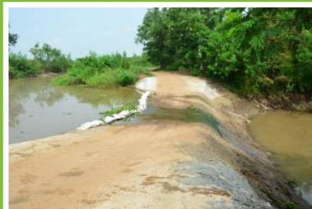
6. งานก่อสร้างฝายน้ำล้นบริเวณที่ นายสว่าง สอนปั้น หมู่ที่ 1 บ้านหนองไม้กอง
