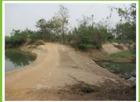
4. งานก่อสร้างฝายน้ำล้นบริเวณที่ นายสว่าง สอนปั้น หมู่ที่ 1 บ้านหนองไม้กอง
