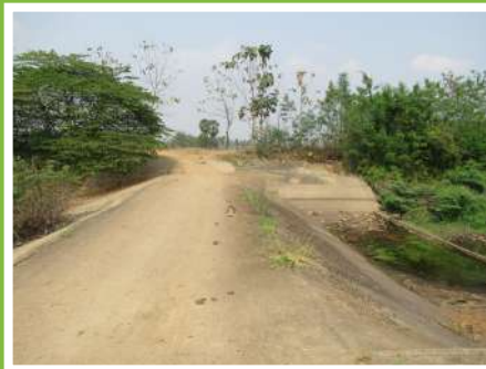
3. งานก่อสร้างฝายน้ำล้นบริเวณที่
