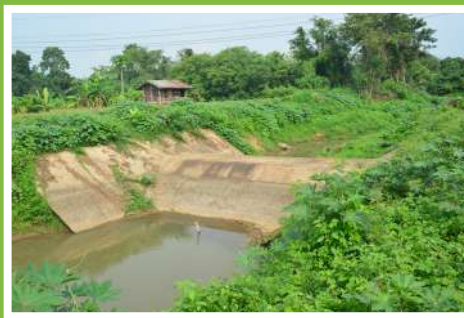
1. งานก่อสร้างฝายน้ำล้นบริเวณที่ นางมา แก้วเกตุ หมู่ที่ 10 บ้านทุ่งพยอมงาม
