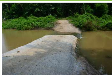
5. งานก่อสร้างฝายน้ำล้นบริเวณหน้าชลประทาน หมู่ที่ 1 บ้านหนองไม้กอง
