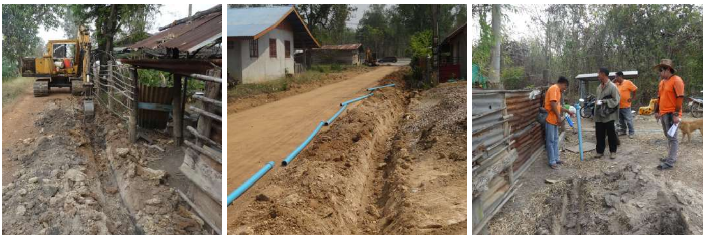
งานวางท่อประปาหมู่บ้าน ซอยช่างหนู หมู่ที่ 1 บ้านหนองไม้กอง ตำบลหนองหญ้าปล้อง อำเภอบ้านด่านลานหอย จังหวัดสุโขทัย งบประมาณ 142,400 บาท
