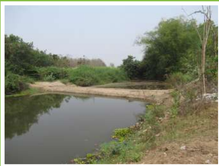
2. งานก่อสร้างฝายน้ำล้นบริเวณที่ นางอรุณี สิริรักษ์ หมู่ที่ 2 บ้านเขาปูน นางพิกุล แก้วทอง หมู่ที่ 3 บ้านหนองจิกดินเนิน
